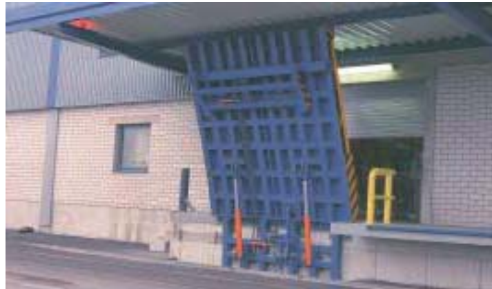
Gleisleger für Waggon-Entladung
