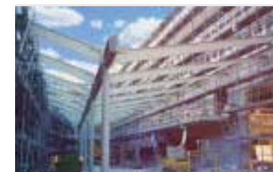
Stahlunterkonstruktion für ein 1200 m 2 großes Glasdach
