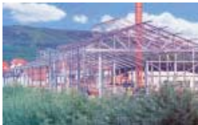
Produktionshalle mit Kranbahnen
