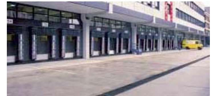
Verladestation der Deutschen Post AG mit über 100 Verladeschleusen
