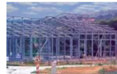
Hallenkonstruktion für Glasproduktion
