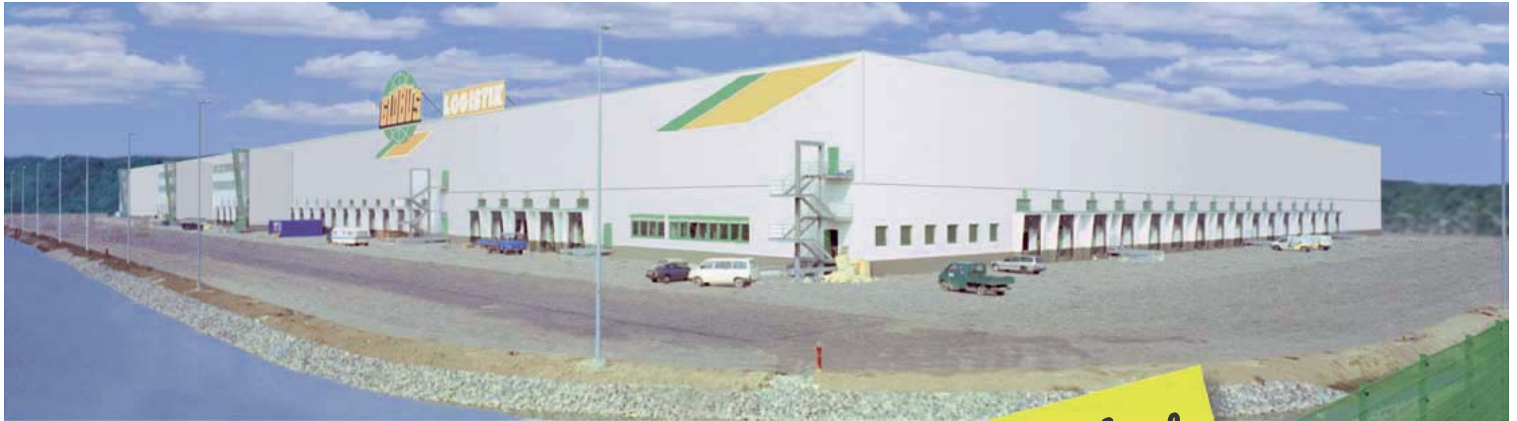
Hochmodernes Logistik-Center bei Bingen am Rhein.
